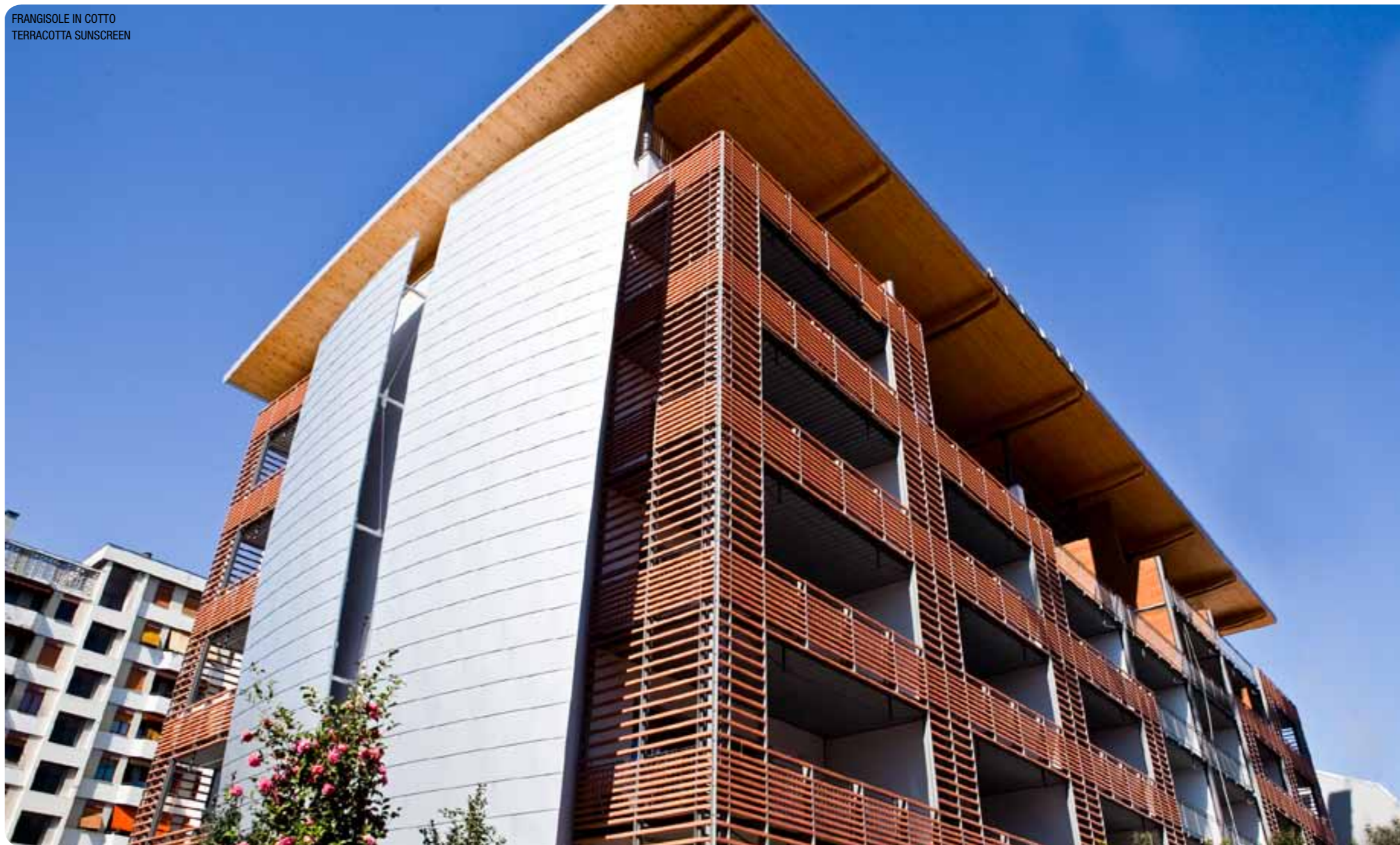
FACCIATA CONTINUA - FACCIATA VENTILATA E FRANGISOLE IN COTTO CURTAIN WALL - VENTILATED CLADDING AND TERRACOTTA SUNSCREEN
