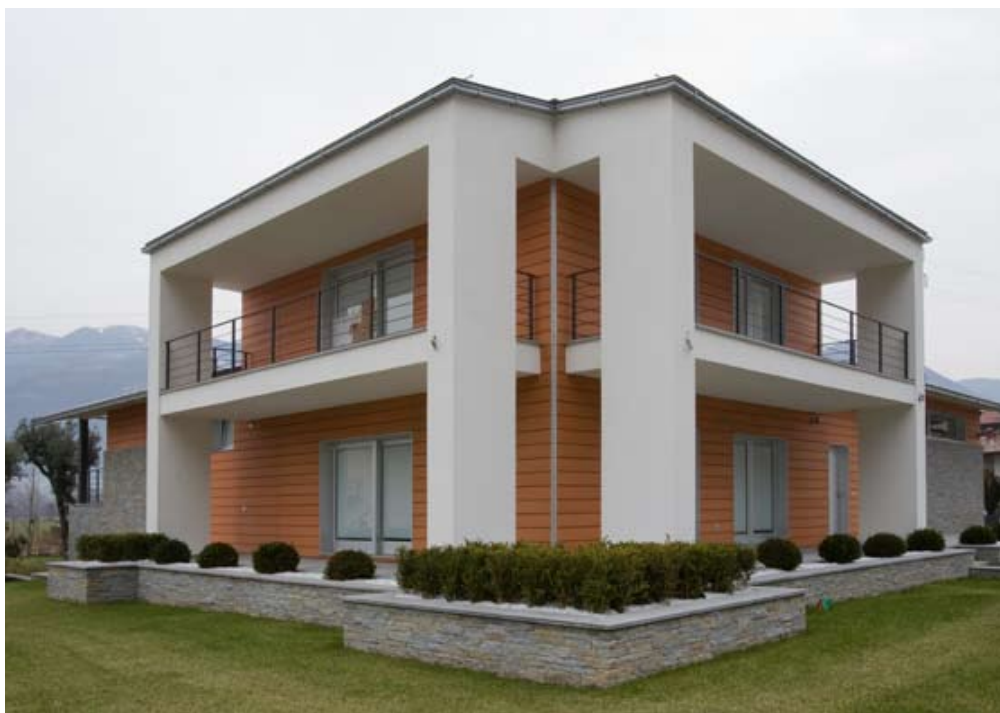
Vista delle logge del corpo principale.
