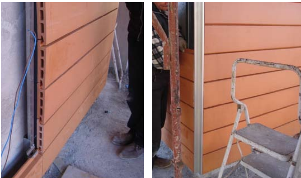
Alcune fasi del montaggio della facciata ventilata in laterizio.
